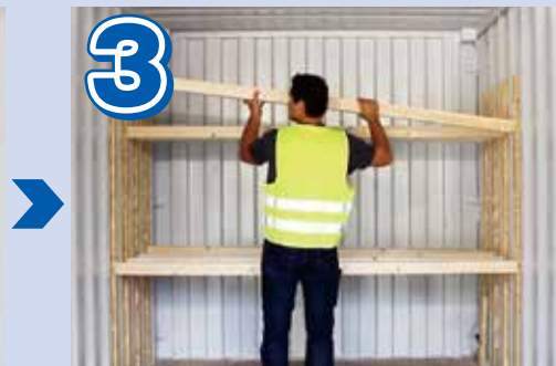
3 左右に挿し込み横棒を抑え込めば完成
