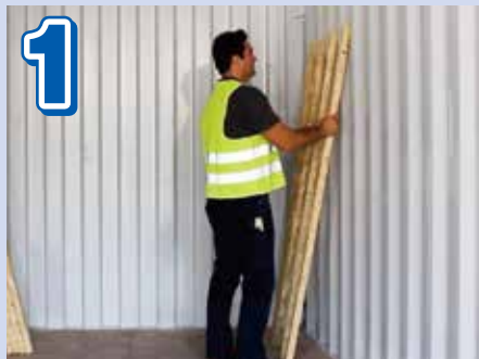
1 コンテナの凹凸に合わせ支柱を設置
